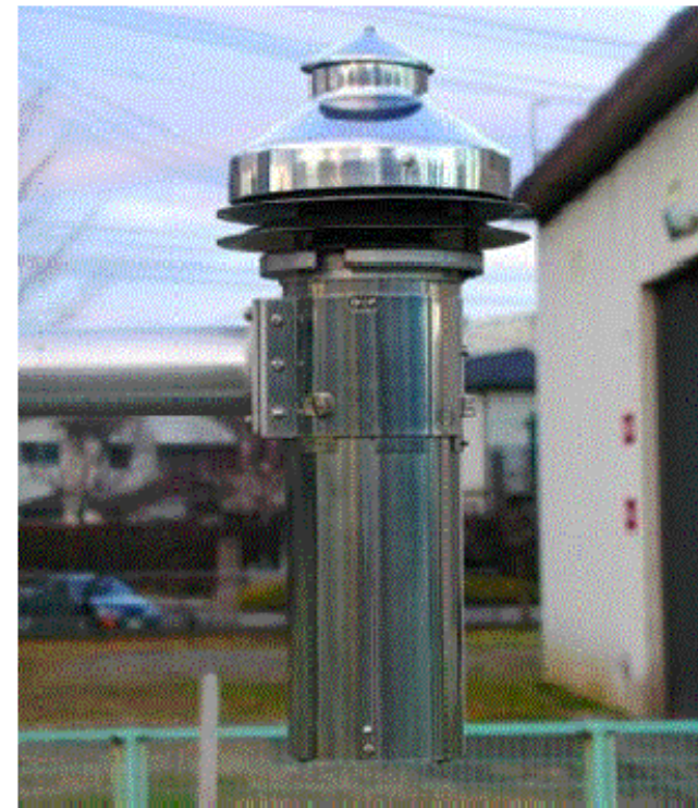
通風筒の外観
