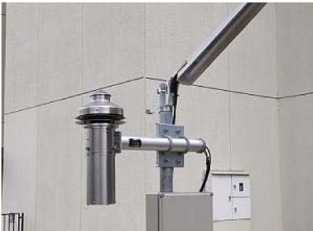
通風筒の外観
