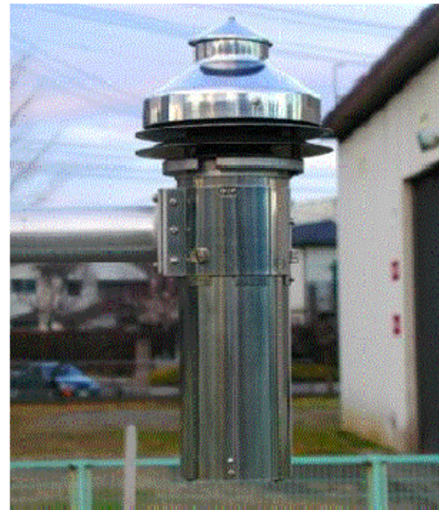
通風筒の外観
